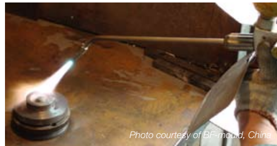
Figura 19 Strat subtire de oxidare minimalizata
